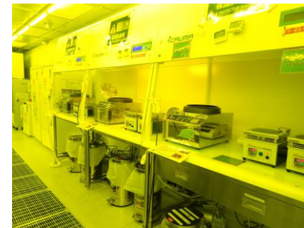
塗布・現像装置
